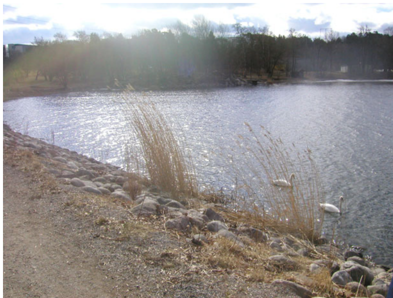
Figur 3 Mörbyviken vid bergtunnelns utlopp.
