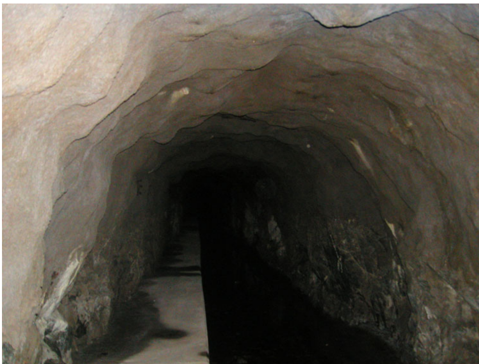
Figur 5 Foto från bergtunneln. Gångklacken med ingjuten spillvattenledning syns till vänster.
